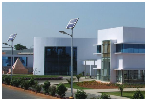
FIGURE 34: LAMPADAIRES SOLAIRES AUTONOMES
